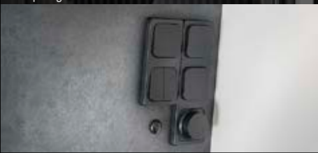
9 Prese di corrente dove servono
